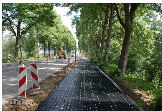
86. attēls. Slodzi izlīdzinošās sistēmas piemērs. Permavold 150mm. Avots: permavoid.co.uk.
