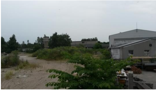
1.foto Skats uz detālplānojuma teritoriju
