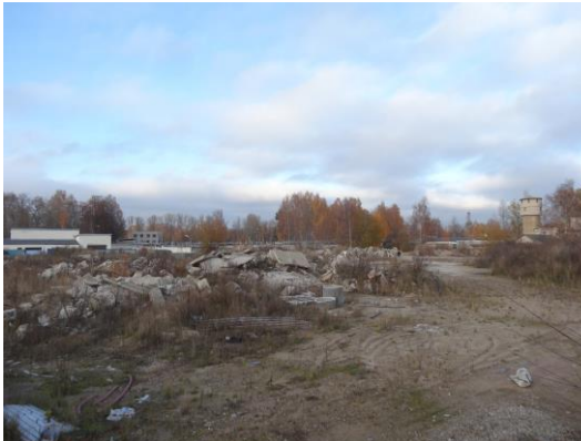
5.foto Skats uz detālplānojuma teritoriju
