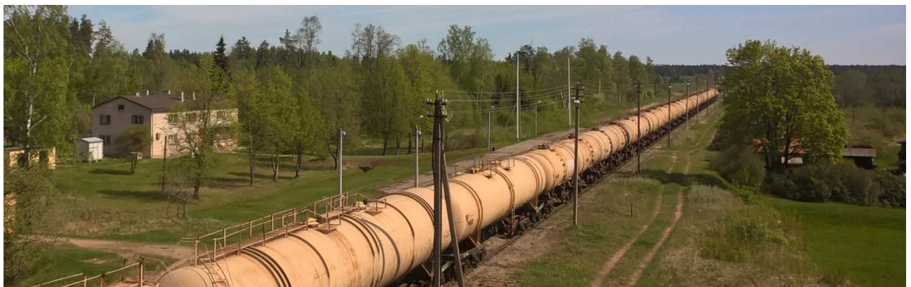
Attēls 41: Skats no valsts reģionālā autoceļa P76 dzelzceļa tiltu (foto P. Grants 8.05.18.)
