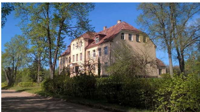
Attēls 25: Bijusī Sēlpils pamatskolas ēka (foto P. Grants 8.05.18.)
