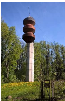
Attēls 43: Ūdenstornis Sēlijas ciemā (foto P. Grants 8.05.18.)
