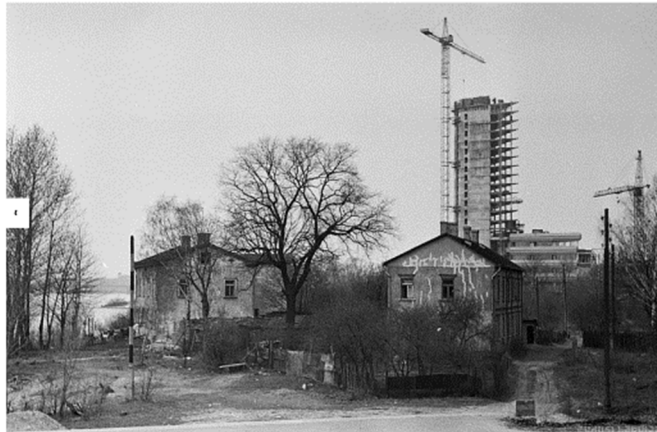
26. attēls. Televīzijas ēku kompleksa būvniecība Zaķusalā. 1984.gads. Datu avots: www.zudusilatvija.lv
