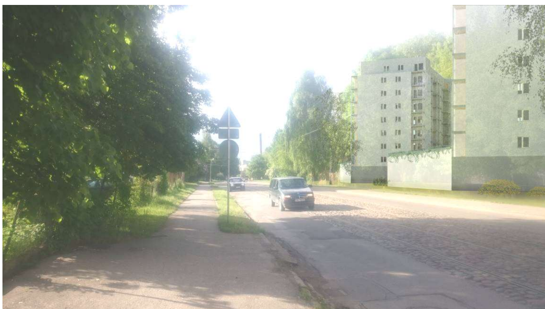
27.attēls. Skats Nr. 3 - no Pļaviņu ielas pieslēguma Maskavas ielai, Slāvu apļa virzienā
