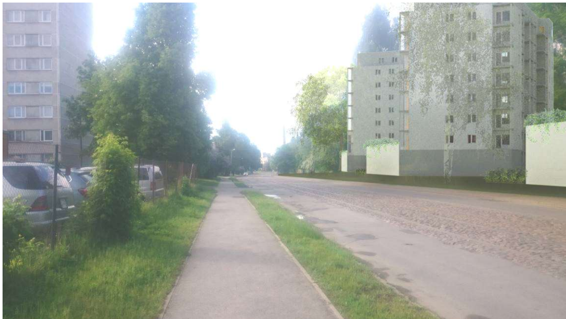
26.attēls. Skatu Nr.2- no Kojusalas ielas prespetīvās pieslēguma vietas Maskavas ielai Slāvu apļa virzienā
