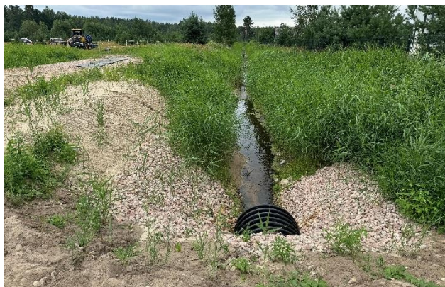
14. attēls. Koplietošanas ūdensnoteka 381224:3 gar Detālplānojuma teritorijas rietumu robežu (skats no Kviešu ielas dienvidu virzienā), 17.07.2024.
