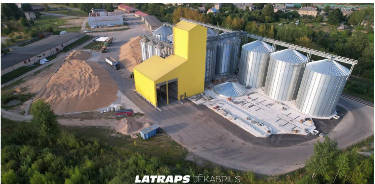
Fotofiksācija. LPKS "LATRAPS" Jēkabpils graudu pirmapstrādes kompleks 8
