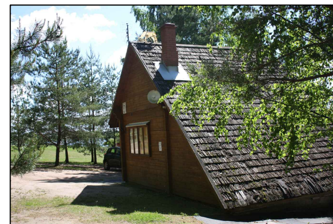
112 Peldvietas administrācijas ēka
