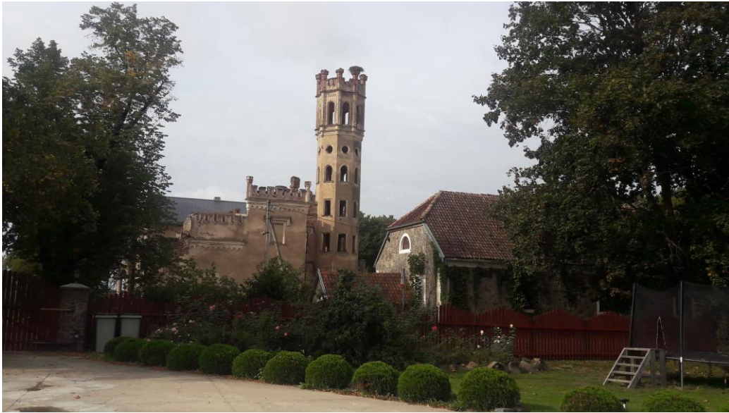
16.attēls. Odziena muiža (foto: I.Murziņa, 2018).
