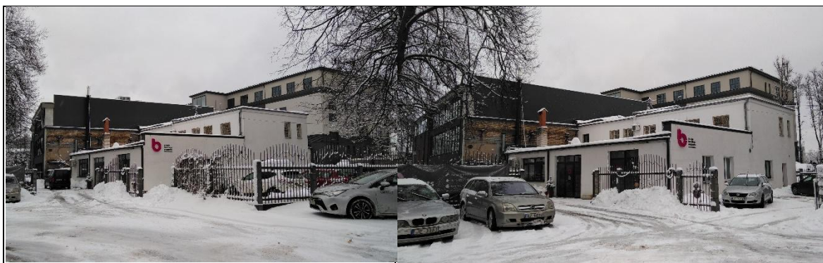
8. attēls. Ēka Mūkusalas ielā 31 A
