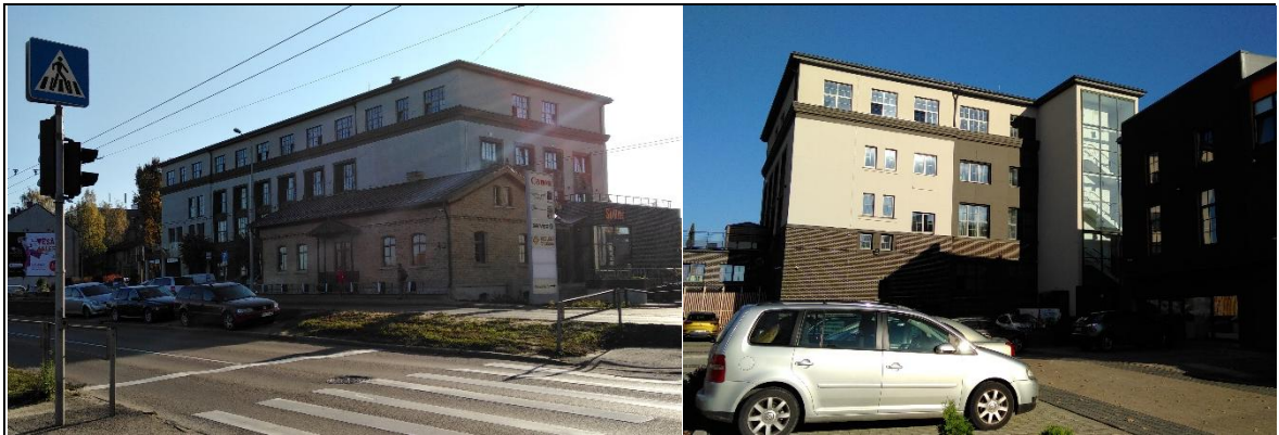
12. attēls. Ēka Mūkusalas ielā 27 un 29
